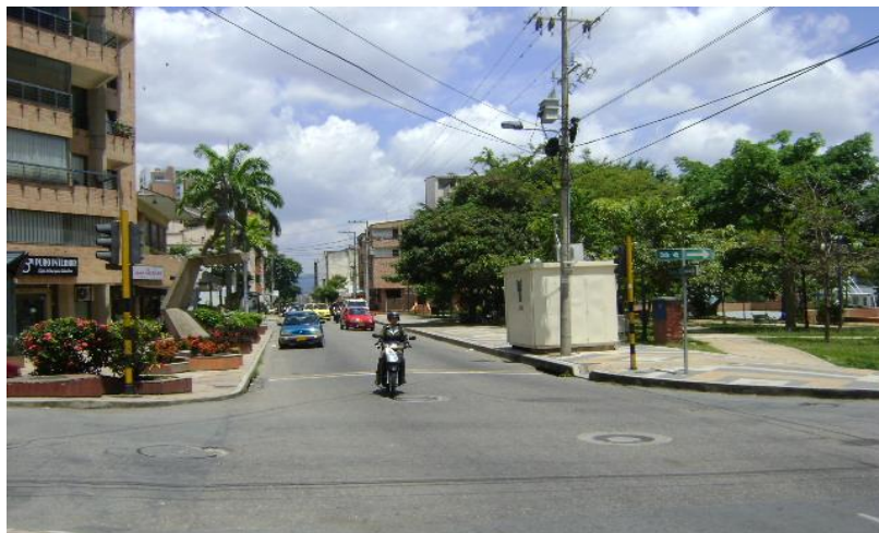
Estacion instalada en el Parque San Pio - Calle 45 con Cra 36
